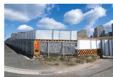
大阪府和泉市和泉いぶき野造成
