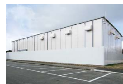
大阪府堺市配水管布設工事
